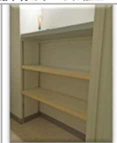
トイレの棚に棚を設置
